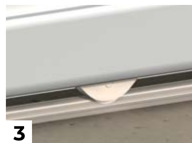
3 Roulette et rail au sol inox
